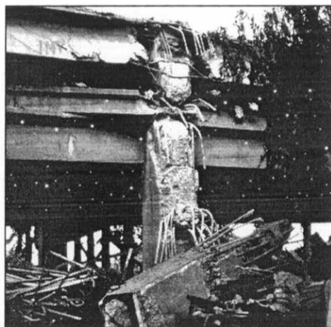
Σχήμα 1.4: Σεισμός της Loma Prieta της 17.10.1989: κατάρρευση γέφυρας υπερυψωμένου αυτοκινητόδρομου (αριστερά) και κατάρρευση γειτονικής κατοικίας (δεξιά) [Lom 89]
