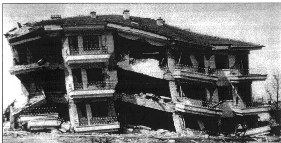
Σχήμα 1.5: Σεισμός Erzincan της 13.3.1992: Καταστροφή κτιρίου κατοικιών και καταστημάτων λόγω καθιζήσεων [WS 93]
