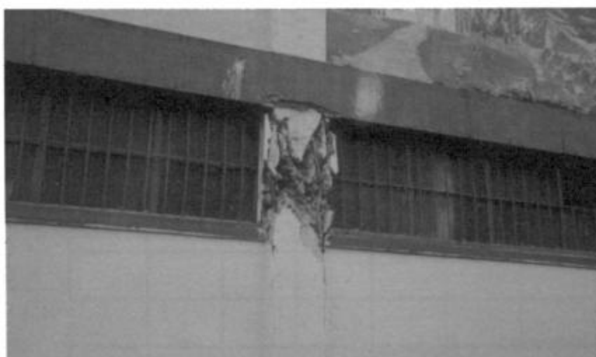
Σχήμα 5.48 Συνέπειες του φαινομένου των κοντών υποστυλωμάτων.
