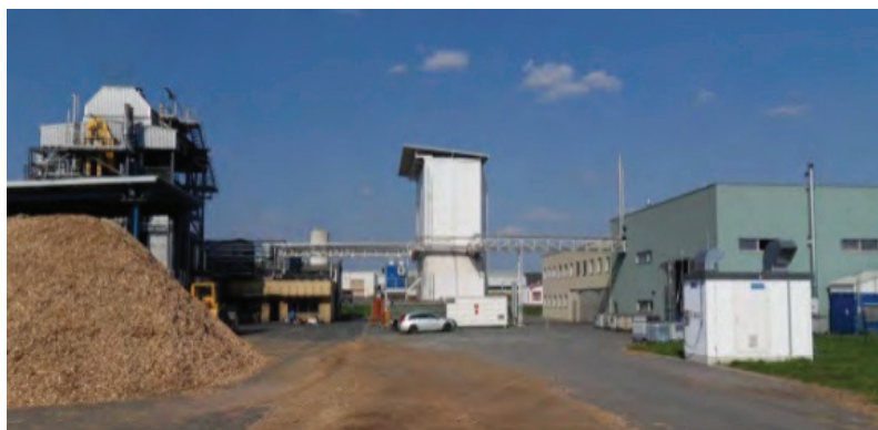
Εικόνα 3: Μονάδα συμπαραγωγής ηλεκτρισμού και θέρμανσης με αεριοποίηση υπολειμμάτων κατεργασίας ξύλου (δυναμικότητα 150 kWh ηλεκτρισμού και 300 kWh θερμότητας, 1 Kg ξηρού ξύλου = 1 kWh ηλεκτρισμού + 2 kWh θερμότητας)
