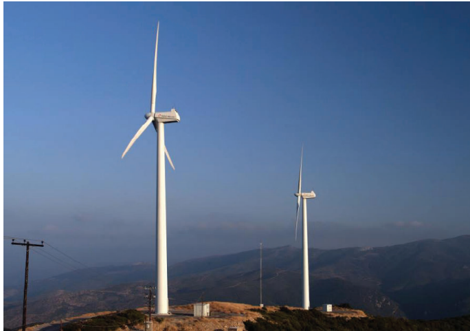
Εικόνα 4 : Φωτογραφία του υπό μελέτη Α/Π και του ανεμολογικού ιστού.
