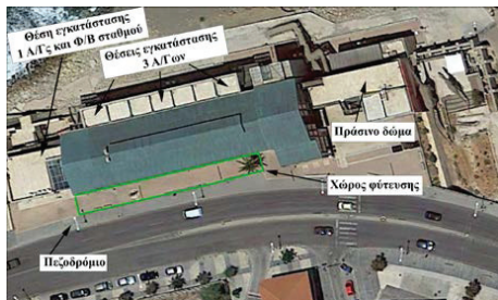
Εικόνα 5α: Δορυφορική κάτοψη κτηρίου ΜΦΙΚ.
