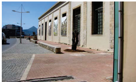
Εικόνα 5β: Χώρος προς φύτευση στη νότια όψη.
