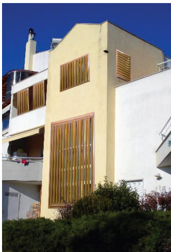
Εικόνα 3: Αποψη της νοτιοδυτικής όψης με τα συστήματα περισίδων
