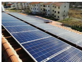
Εικόνα 2. Αυτόνομο φωτοβολταϊκό σύστημα επί κεραμοσκεπής
