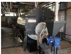
Εικόνα 3. Λέβητας βιομάζας (αριστερά), ηλιακό πεδίο (κέντρο), σύστημα αποθήκευσης ζεστού νερού και βιομάζας (δεξιά)
