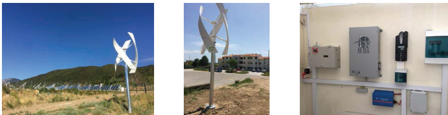
Εικόνα 5. Μικρής Α/Γ και σύστημα διαχείρισης της παραγόμενης ενέργειας
