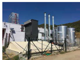
Εικόνα 3. Λέβητας βιομάζας (αριστερά), ηλιακό πεδίο (κέντρο), σύστημα αποθήκευσης ζεστού νερού και βιομάζας (δεξιά)
