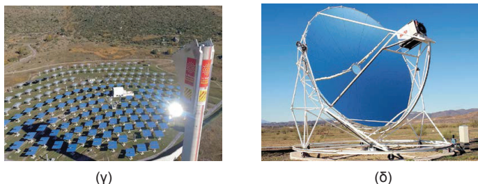
Εικόνα 1: Συστήματα ΣΘΗ τεχνολογιών (α) παραβολικού τύπου (β) τύπου κατόπτρων Fresnel (γ) ηλιακού πύργου ισχύος και δίσκου μηχανής [2]
