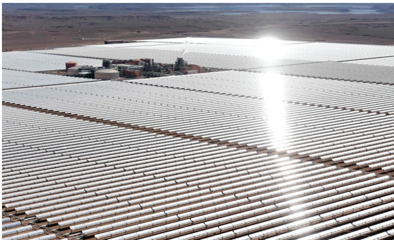
Εικόνα 3: Το ηλιακό πάρκο Noor στην περιοχή Ouarzazate του Μαρόκου που, όταν ολοκληρωθεί (σύμφωνα με τον προγραμματισμό, το 2018), η ισχύς του θα φτάνει τα 580 MW και θα είναι το μεγαλύτερο στον κόσμο.
