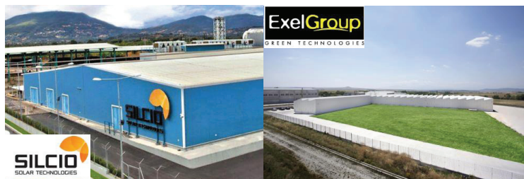
Εικόνες 4,5 : Άποψη εγκαταστάσεων της Silcio και της Exel Group.
