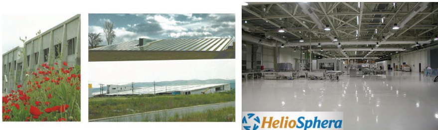
Εικόνες 6,7 : Άποψη των ημιτελών εγκαταστάσεων της Ηλιοδομής και της Heliosphera.
