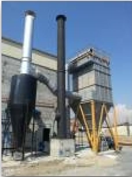
Αποκονίωση λέβητα καύσης βιομάζας
