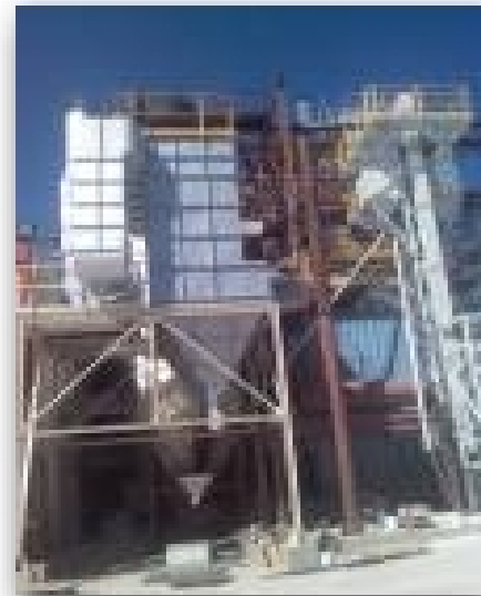
Αποκονίωση φούρνου διόγκωσης Περγλίτη
