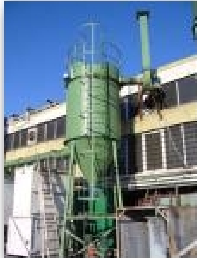
Αποκονίωση χυτηρίου μετάλλων στον Ασπρόπυργο
