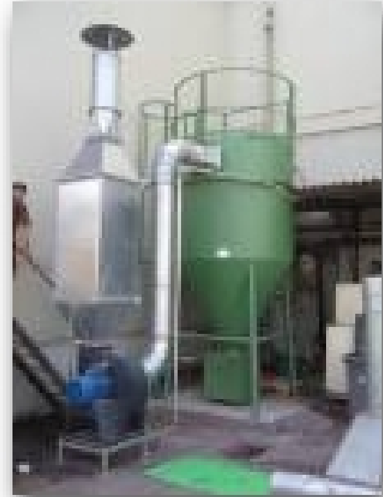
Αποκονίωση χώρου παραλαβής κακάο σε βιομηχανία παραγωγής σοκολάτας
