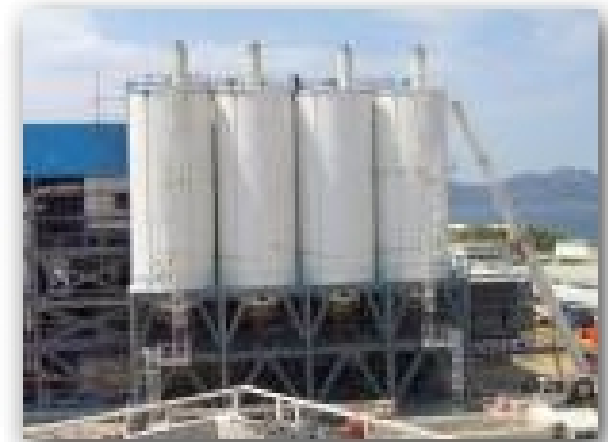
Αποκονίωση 4 σιλό ξηραμένης λυματολάσπης στην Ψυτάλεια με φίλτρα ATEX
