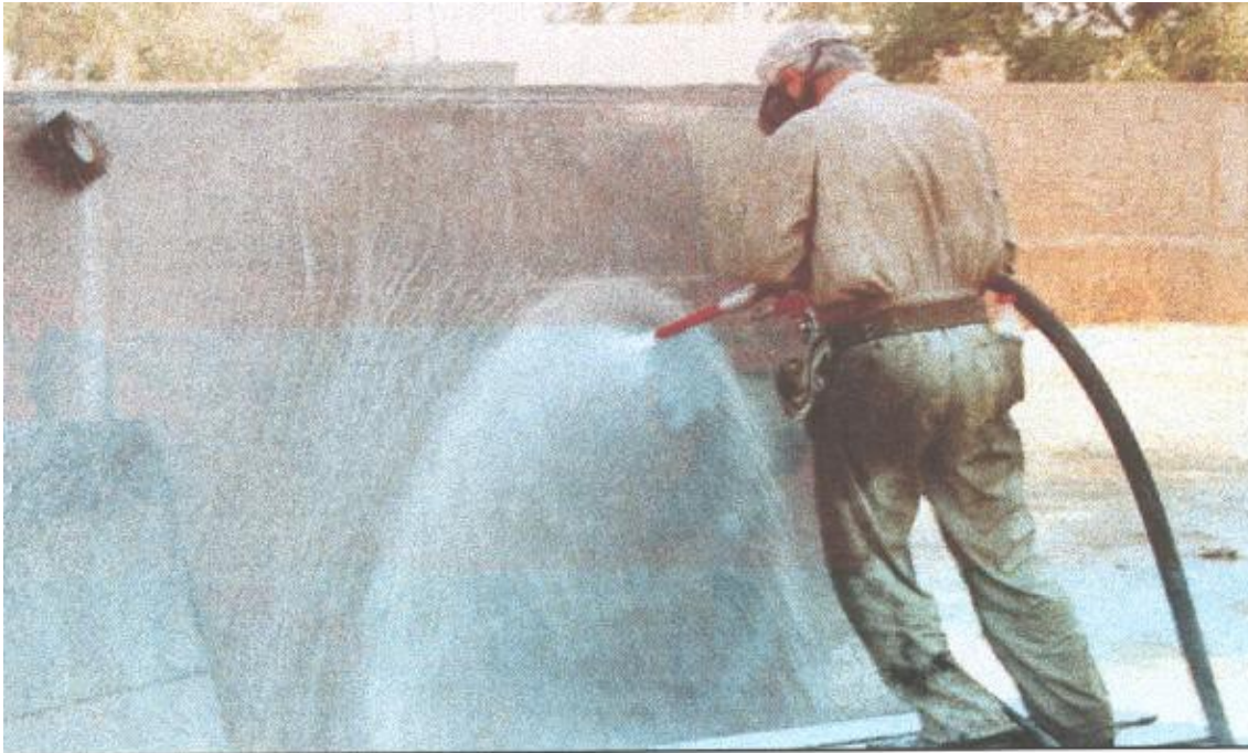
Εικόνα 6: Υδροαμμοβολή με τη μέθοδο έγχυσης αποξεστικού.
