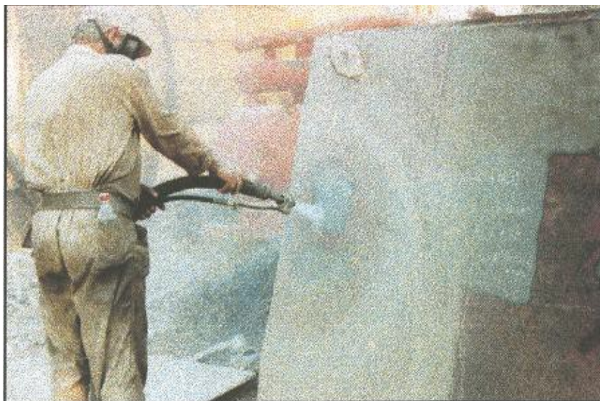
Εικόνα 2: Υδροαμμοβολή με κουρτίνα νερού.
