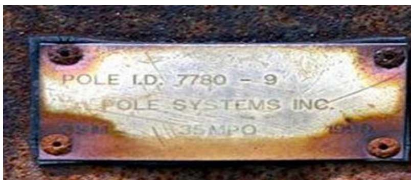
Εικόνα 2 Γαλβανική διάβρωση (χάλυβας, χαλκός)
