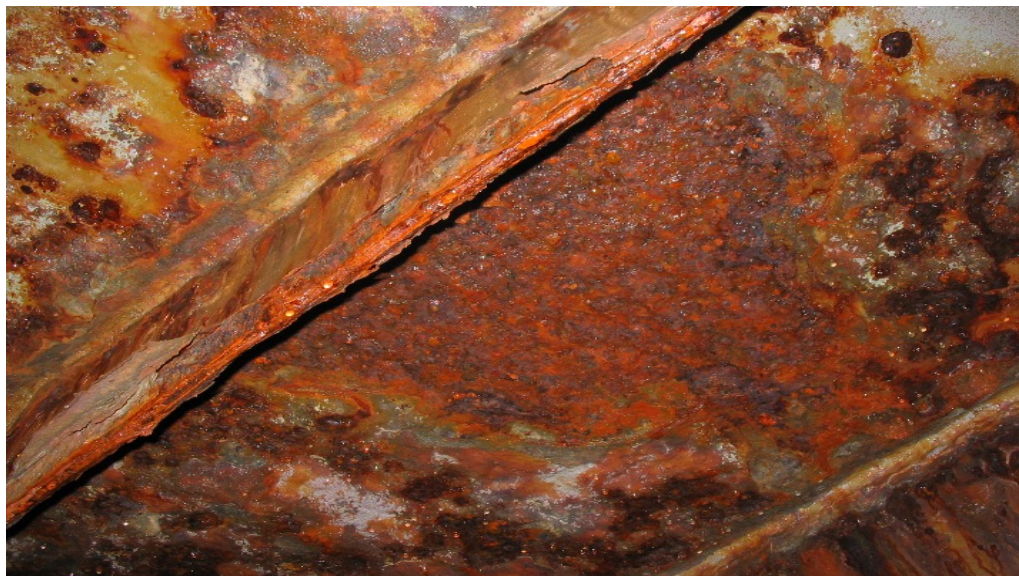
Εικόνα 1: Ομοιόμορφη διάβρωση
