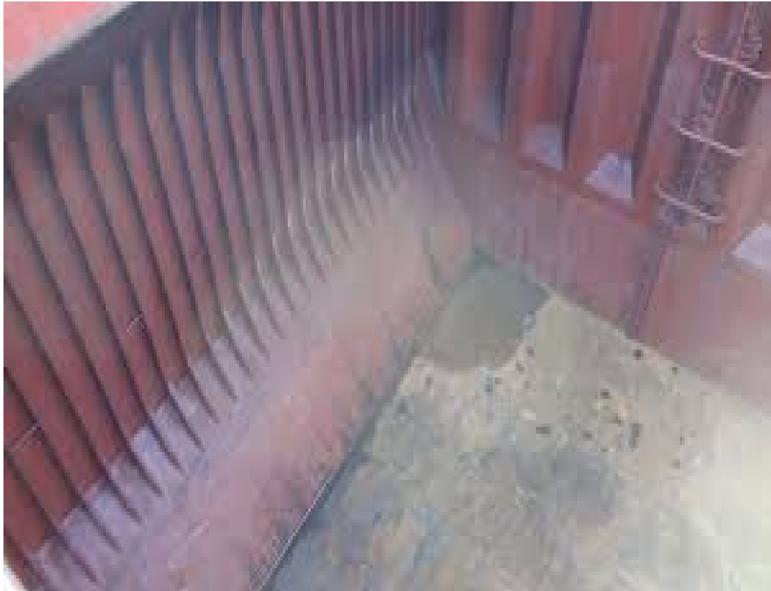
Εικόνα 7: Αμπάρι Bulk Carrier με κυματοειδή φρακτή.
