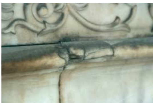
Φωτογραφία 3.12: Πράσινες δυσχρωμίες και ρωγμές στη βάση του ανδριάντα του Θεόδωρου Κολοκοτρώνη στην Αθήνα (φωτ. Β. Βασιλειάδης 2001).
