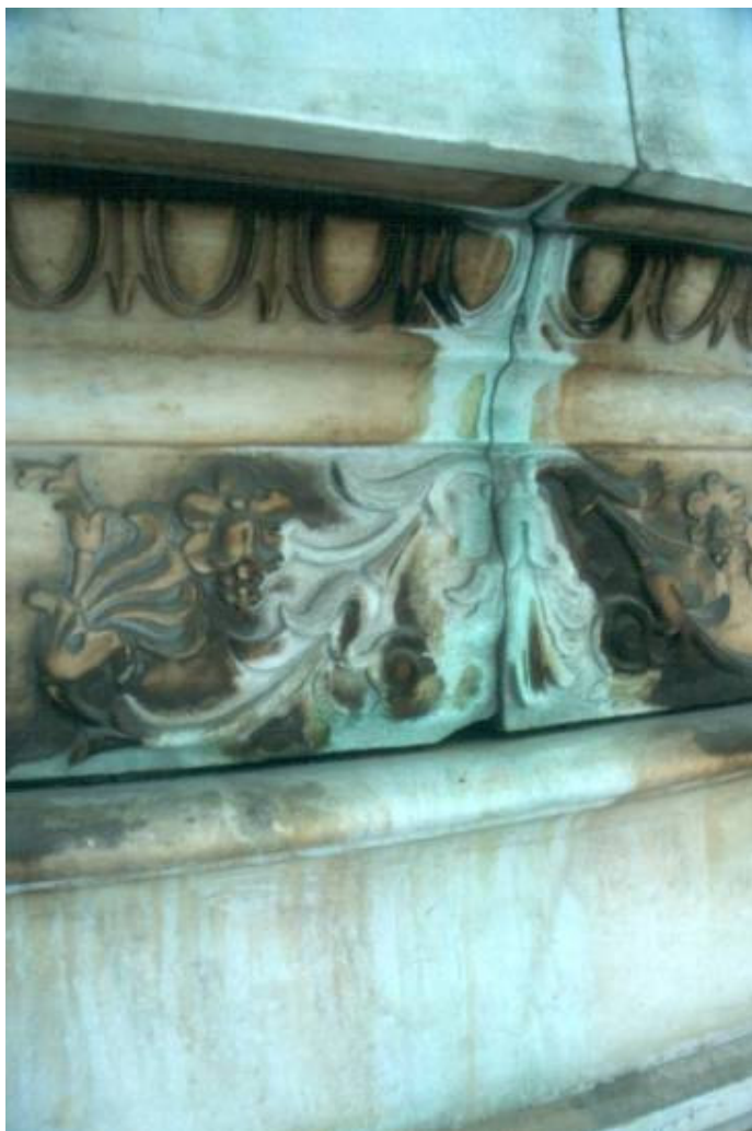
Φωτογραφία 2.9: Ανδριάντας Θεόδωρου Κολοκοτρώνη, Αθήνα: Χρωματικές αλλοιώσεις στη βάση λόγω οξειδωσης μεταλλικών στοιχείων
