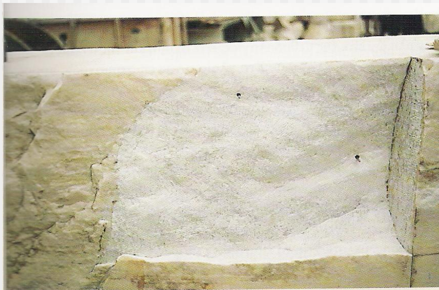
6: Μετά την απομάκρυνση του θραύσματος αποκαλύπτεται η ανάπτυξη βιολογικής παρουσίας στην επιφάνεια θραύσης.
