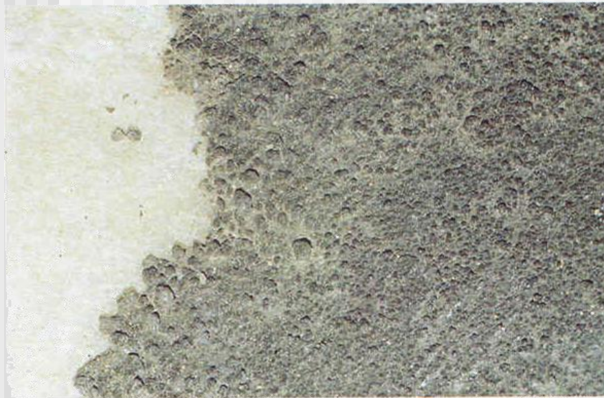
Φωτ. 123. Γείσο 14001/δ. Κρούστα με ανακρυσταλλώσεις.
