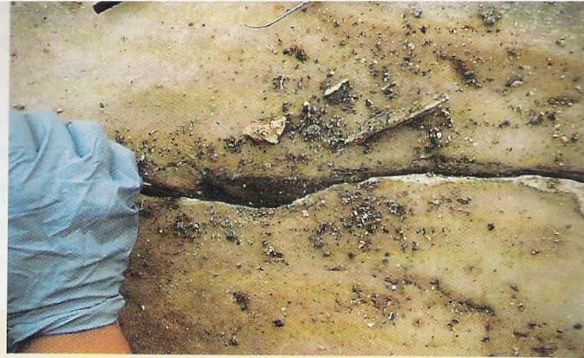
2: Η αφαίρεση των προηγούμενων κονιαμάτων γίνεται με λιθοξοϊκά εργαλεία.
