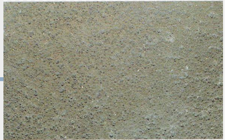
Φωτ. 122. Γείσο 14001/δ. Κρούστα με καλή πρόσφυση στην επιφάνεια του μαρμάρου.
