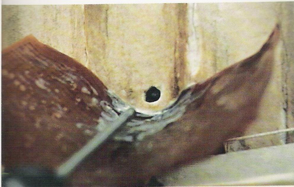
2: Η αφαίρεση των προηγούμενων κονιαμάτων γίνεται με λιθοξοϊκά εργαλεία.
