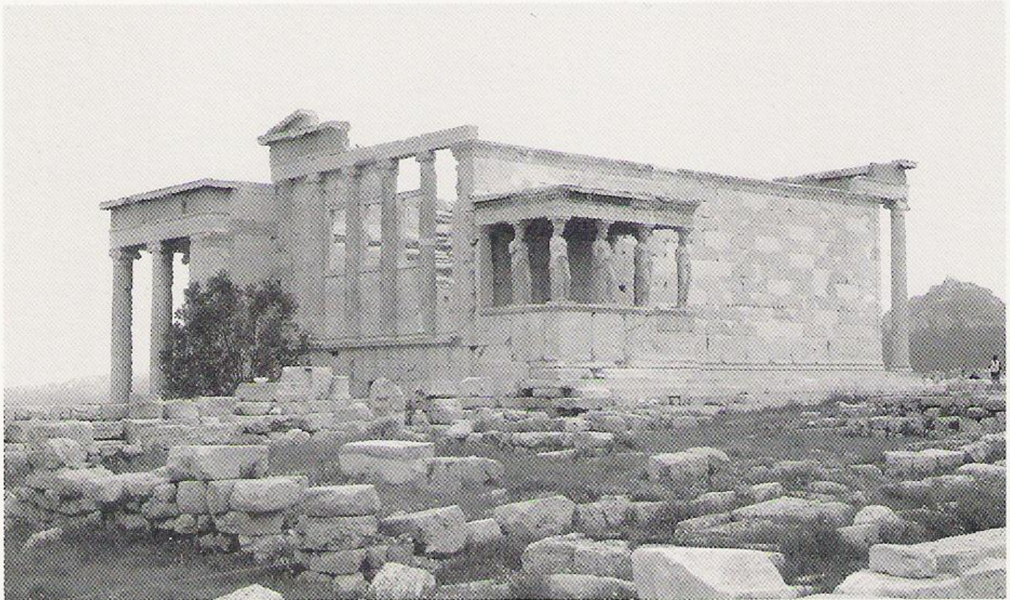
Άποψη του Ερεχθείου από ΝΔ το 1987. Φωτ. Σ. Μαυρομμάτης
