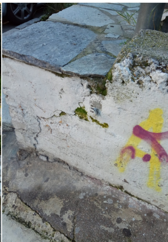
Φωτ. 12: R11 (Ανατολική Πύλη)
